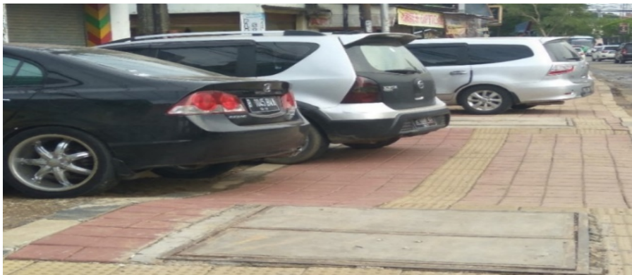
Gambar 1. Keadaan Trotoar Jl. Trip Jamaksari Kota Serang Tahun 2018, trotoar khusus (Guiding block) bagi disabilitas netra yang digunakan bagi tempat parkir.
