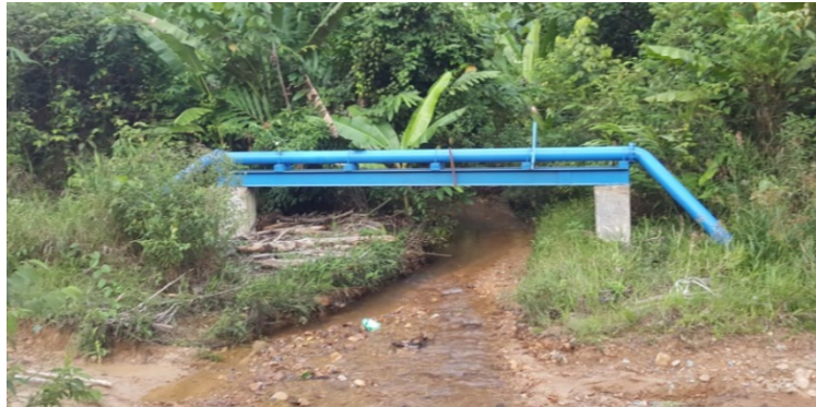
Gambar 6. Pipa Distribusi di Kampung Long Bagun yang belum berfungsi (1) Sumber: Peneliti, 2024
