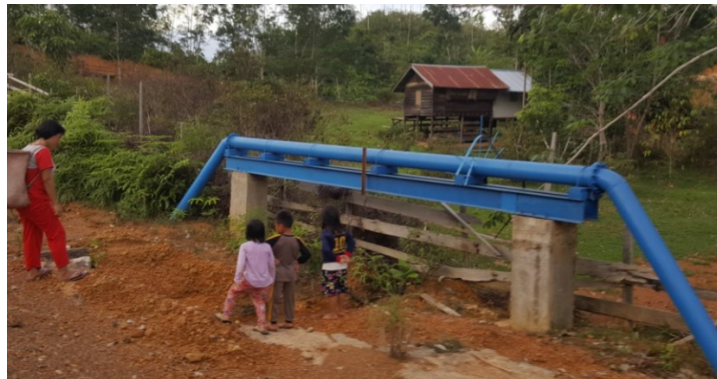
Gambar 7. Pipa Distribusi di Kampung Long Bagun yang belum berfungsi (2) Sumber: Peneliti, 2024
