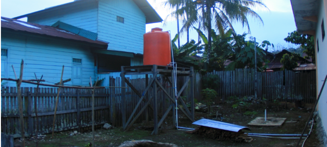
Gambar 3. Proses Pengendapan dan Penampungan Air Warga Sumber: Peneliti, 2024
