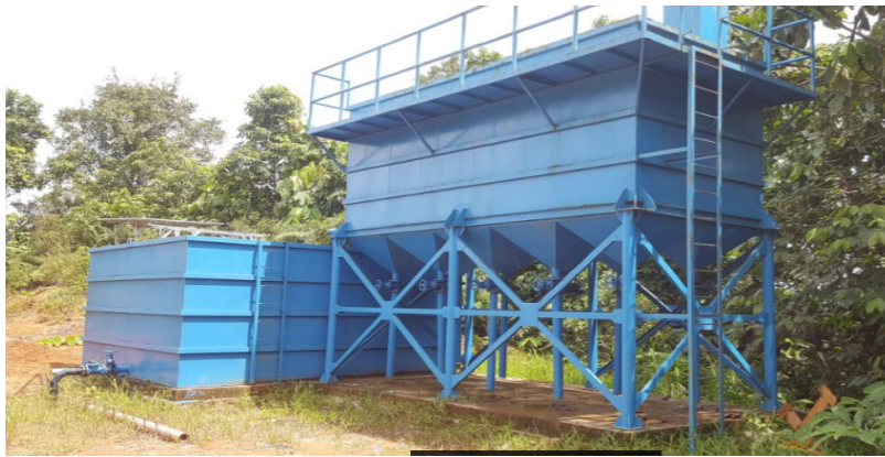
Gambar 10. Tangki Air yang belum difungsikan di Long Pahangai Sumber: Peneliti, 2024
